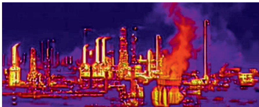
Тепловизионный мониторинг факельной установки с дроном DJI
