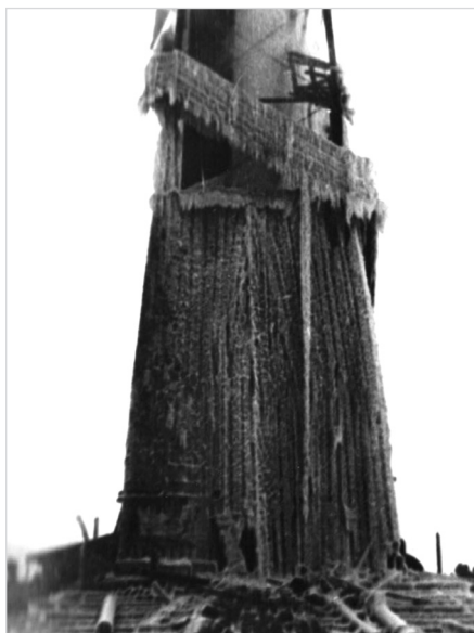
Рис. 4. Скважина Р-1 после открытого фонтана
