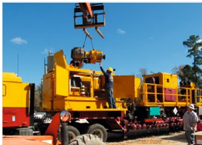
Рис. 2 — Монтаж газотурбинного двигателя на агрегат приготовления смеси фирмы МТТ
