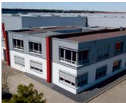
Здание центрального офиса в Бедбурге.
