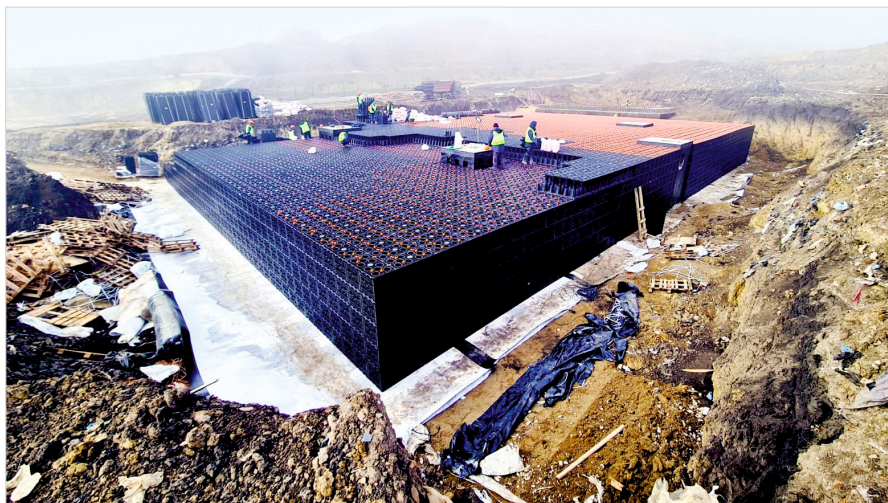
Монтаж резервуара «БлокТех»
