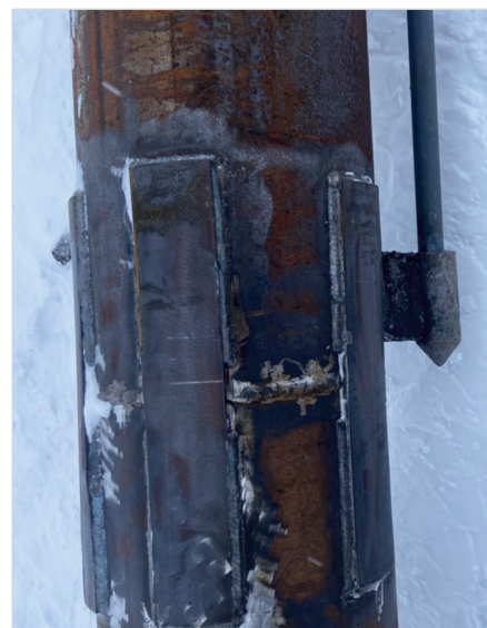
Рис. 10. Погружение сваи СОУ Fig. 10. Driving the seasonal cooling device pile
