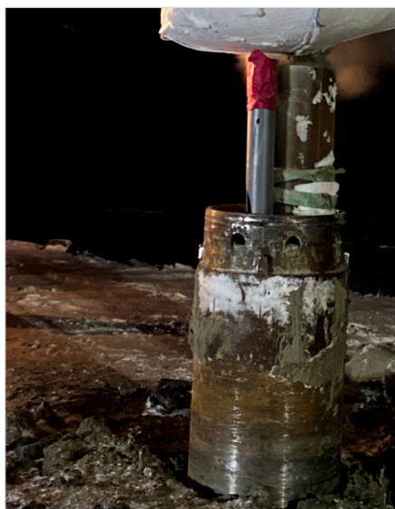
Рис. 9. Крепление СОУ к телу сваи Fig. 9. Fastening the seasonal cooling device to the pile body
