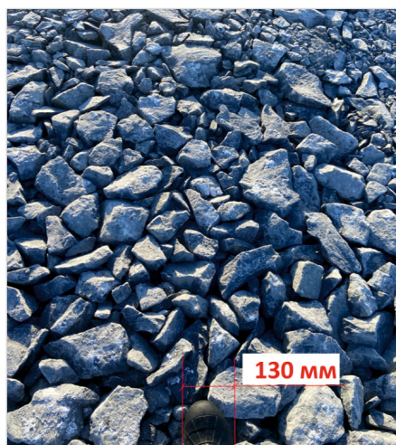
Рис. 4. Устройство насыпи из крупнообломочной скальной породы фракции 0–300 мм
