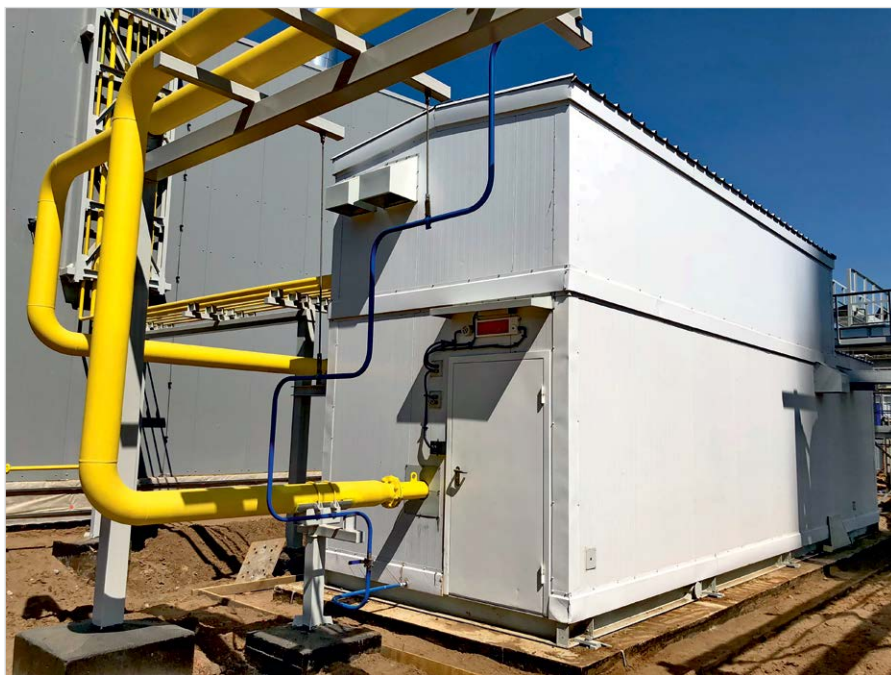
Фото 3. Блочный пункт очистки газа входит в состав системы газоподготовки для ГТУ-ТЭС в Елабуге
