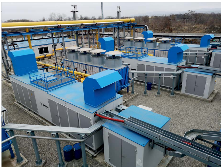
Фото 8. Дожимная компрессорная станция обеспечивает топливным газом турбины Грозненской ТЭС
