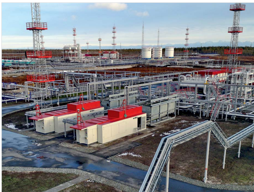
Фото 4. Дожимные компрессорные установки для перекачивания ПНГ на Южном Ватлоре (ХМАО)
