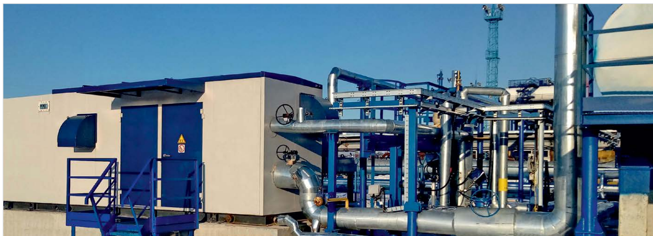
Фото 1. Система подготовки ПНГ низких ступеней сепарации на Вынгапуровском месторождении
