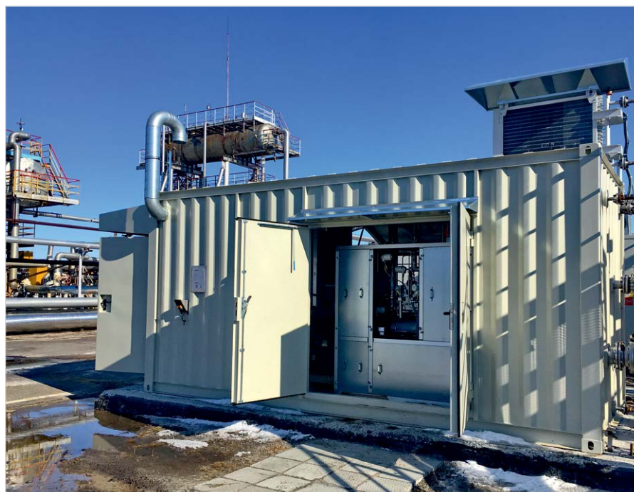
Фото 6. Малая газокompрессорная установка на площадке ДНС-2 Конитлорского месторождения
