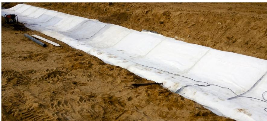
Укрепление водоотвода бетонным полотном
