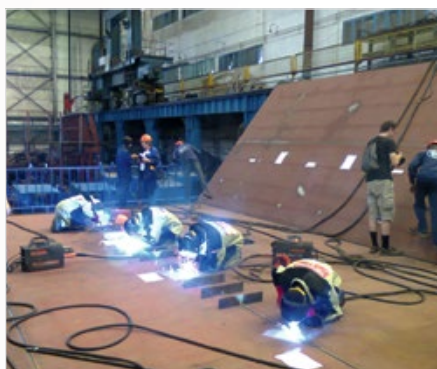
Рис. 1 — Конкурс сварщиков 2013 года, сварка ведется в нижнем положении на керамической подкладке
