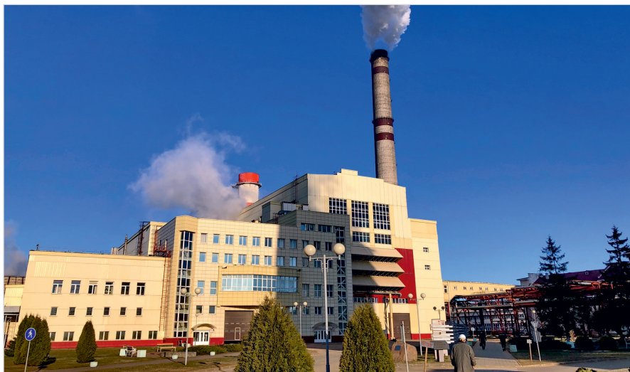
Фото 1. Парогазовый энергоблок ПГУ-230 Минской ТЭЦ-3
