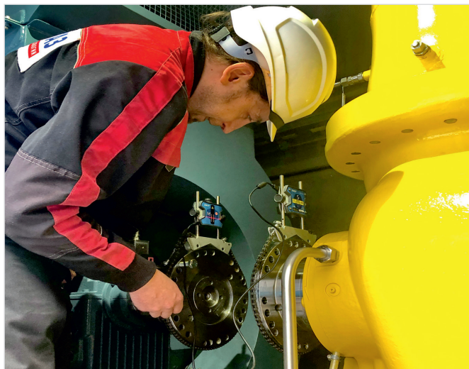
Фото 6. Комплексный ввод оборудования выполнили специалисты компании СервисЭНЕРГАЗ
