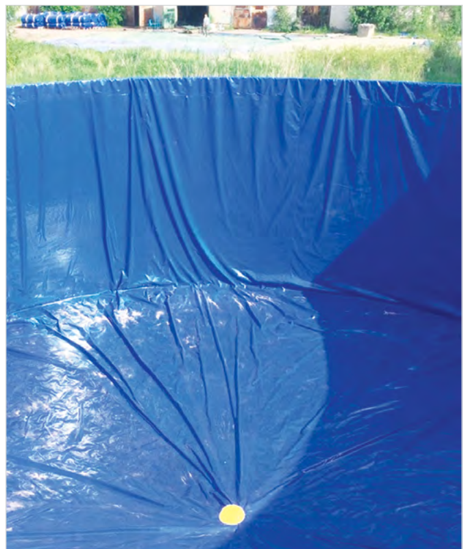
Сборка гибридного резервуара, вид внутри
