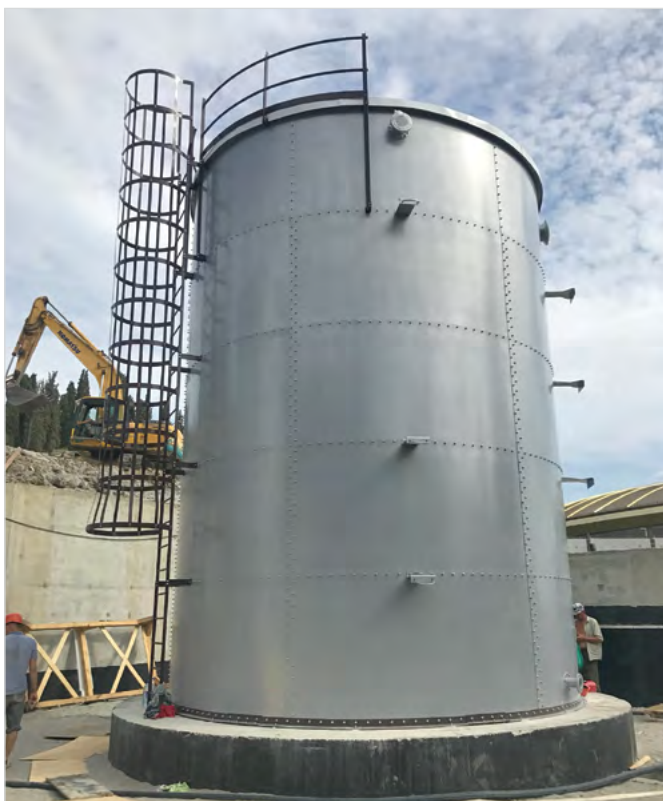
Сборный гибридный резервуар, оснащенный эластичным вкладышем
