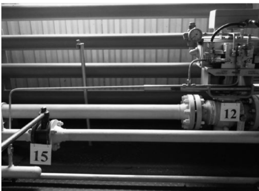
Рис. 9 — Сбор выхлопов с привода на свечной коллектор
