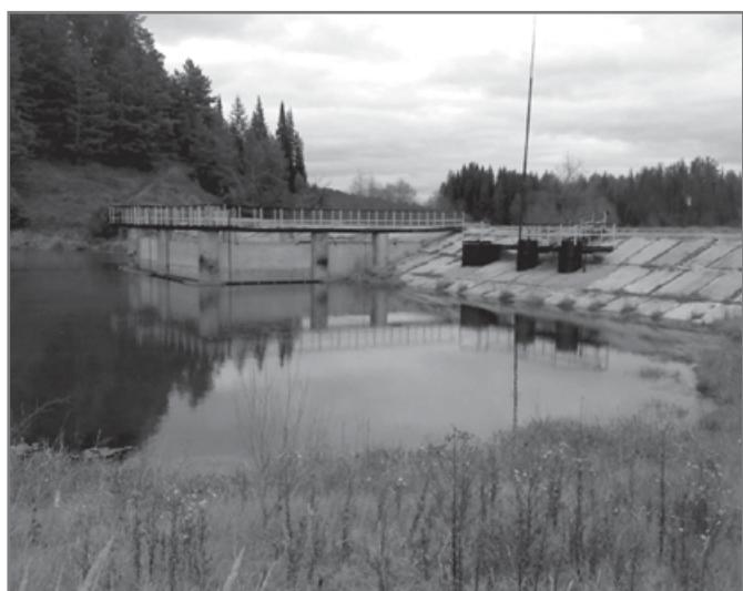
Рис.3. Капитальное гидротехническое сооружение – нефтеповушечная плотина
