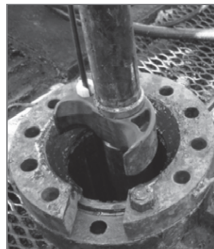
Рис. 3. Спуск колонны труб в скважину с децентратором
