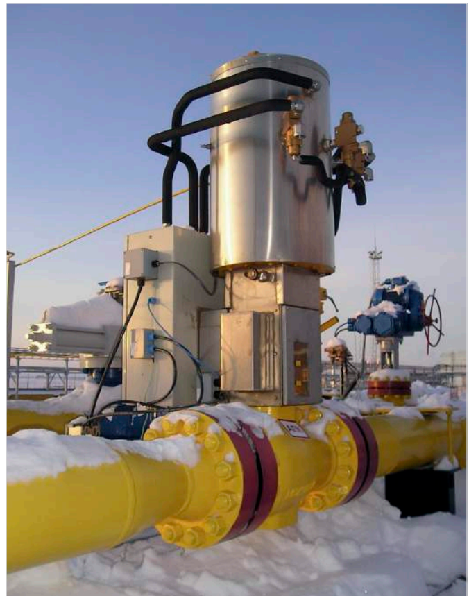
Антипомпажный клапан 10"/ANSI 600 на Канчурино-Мусинском комплексе ПХГ (ПАО «Газпром», Россия)
