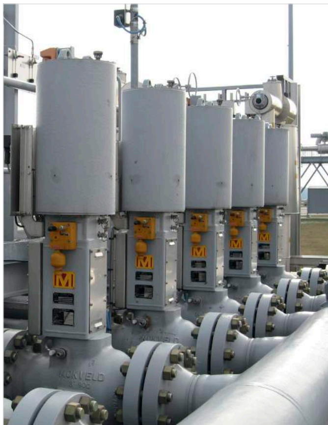
Отсечные клапаны 8"/ANSI 900 на Гронингском месторождении газа (Nederlandse Aardolie Maatschappij, Голландия)
