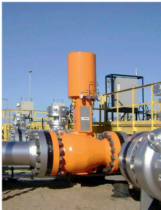
Отсечной клапан 28"/ANSI 1500 на УКПГ Какимбас (Petrobras, Бразилия)
