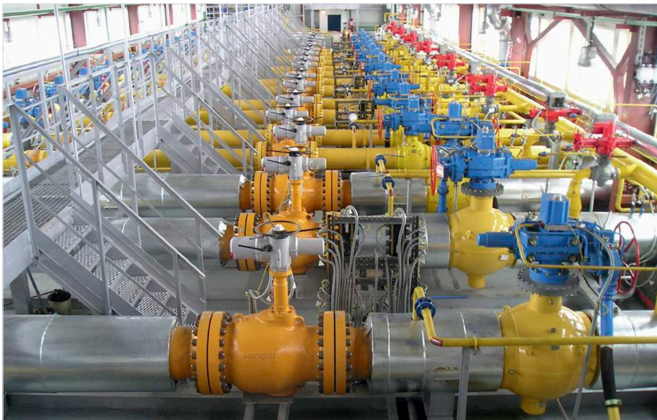
Регулирующие клапаны 12"/ANSI 900 на Ямбургском НГКМ (ПАО «Газпром», Россия)
