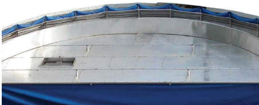
Фото 1 — Блочный алюминиевый понтон для резервуаров РВСП-200...50 000пп
