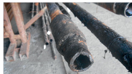
Рис. 4. Обрыв штанги на скважине № 9802 Fig. 4. Rod parting at the well № 9802
