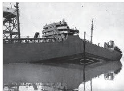
Рис. 1. Танкер “Schenectady” после развала на две части [1]
