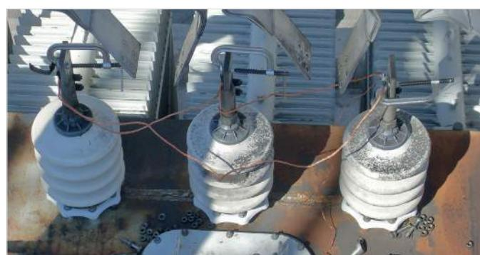
Рис. 2 – Пример закорачивания выводов вторичной обмотки
