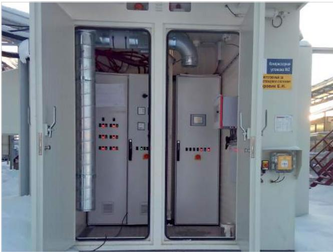
*Фото 5 – Отсек САУ расположен внутри блок-модуля компрессорной установки*
