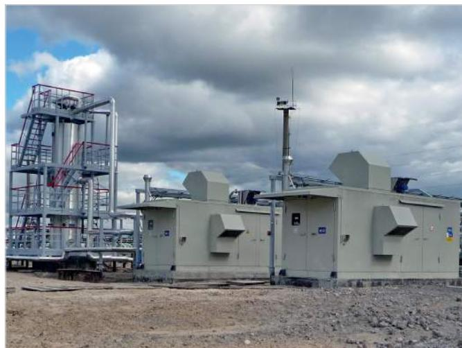
Фото 2 – Компрессорные установки низкого давления на ЦПН НГДУ «Комсомольскнефть»
