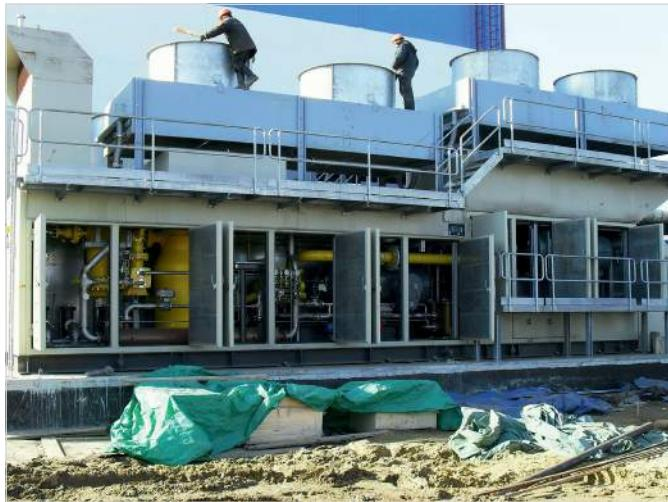
*Фото 6 – Монтаж аппарата воздушного охлаждения на компрессорную установку*
