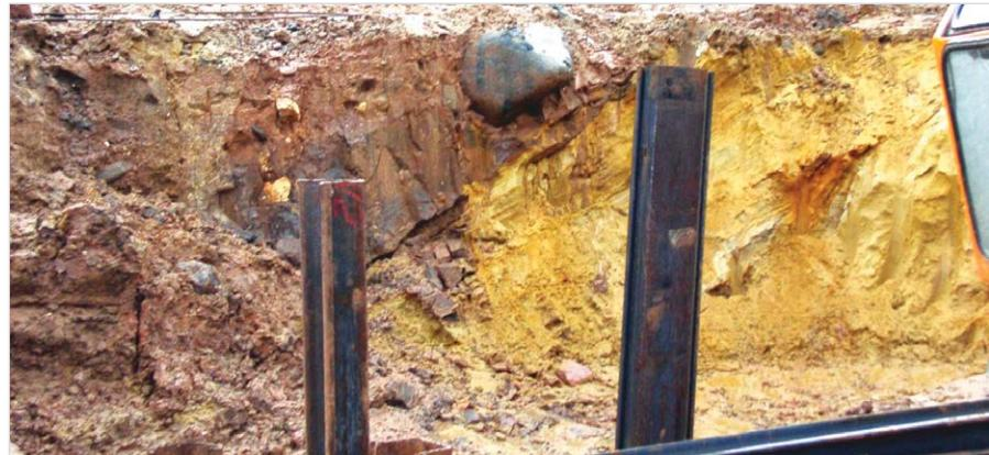
Рис. 1 — Вскрытая часть геологического разреза подводного перехода магистрального нефтепровода Сургут – Погост через р. Улейма в месте остановки дюкера при протаскивании
