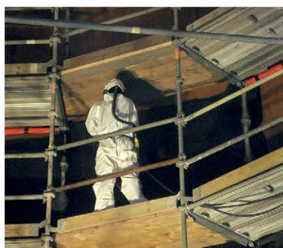
Нанесение покрытия КОРРОПАЙП СЕМ 50 пульверизацией в резервуаре для сырой нефти
