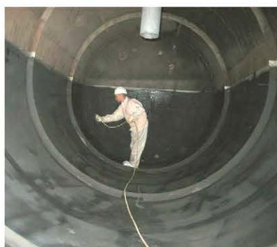
Нанесение покрытия КОРРОПАЙП СЕМ 50 пульверизацией в слоп-танке
