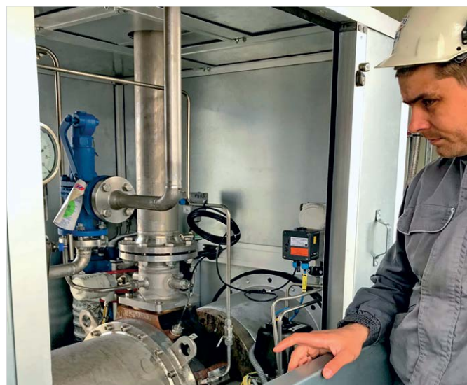
Фото 9 — Собственные испытания оборудования завершают этап пусконаладочных работ
