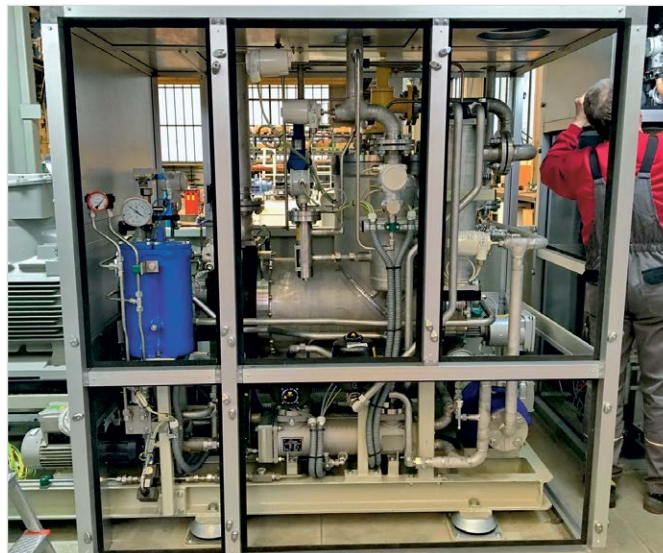
Фото 2 — Малая газокomppressorная установка на этапе сборки
