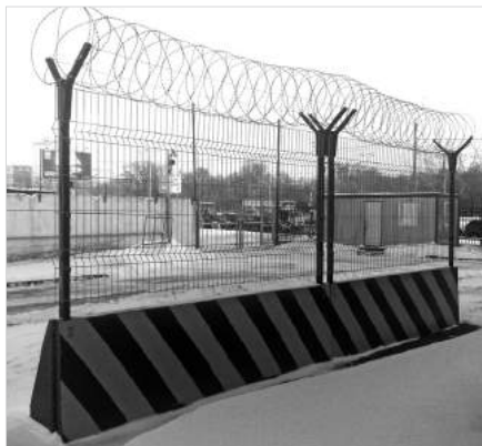
Рис. 1 — Ограждение разрабатывалось с учетом возможности его быстрой и многократной установки на местности, последующего демонтажа и перевозки. При этом бетонные блоки перемещают автопогрузчиком или краном, для чего в составе блока предусмотрены все необходимые для этого конструкционные элементы
